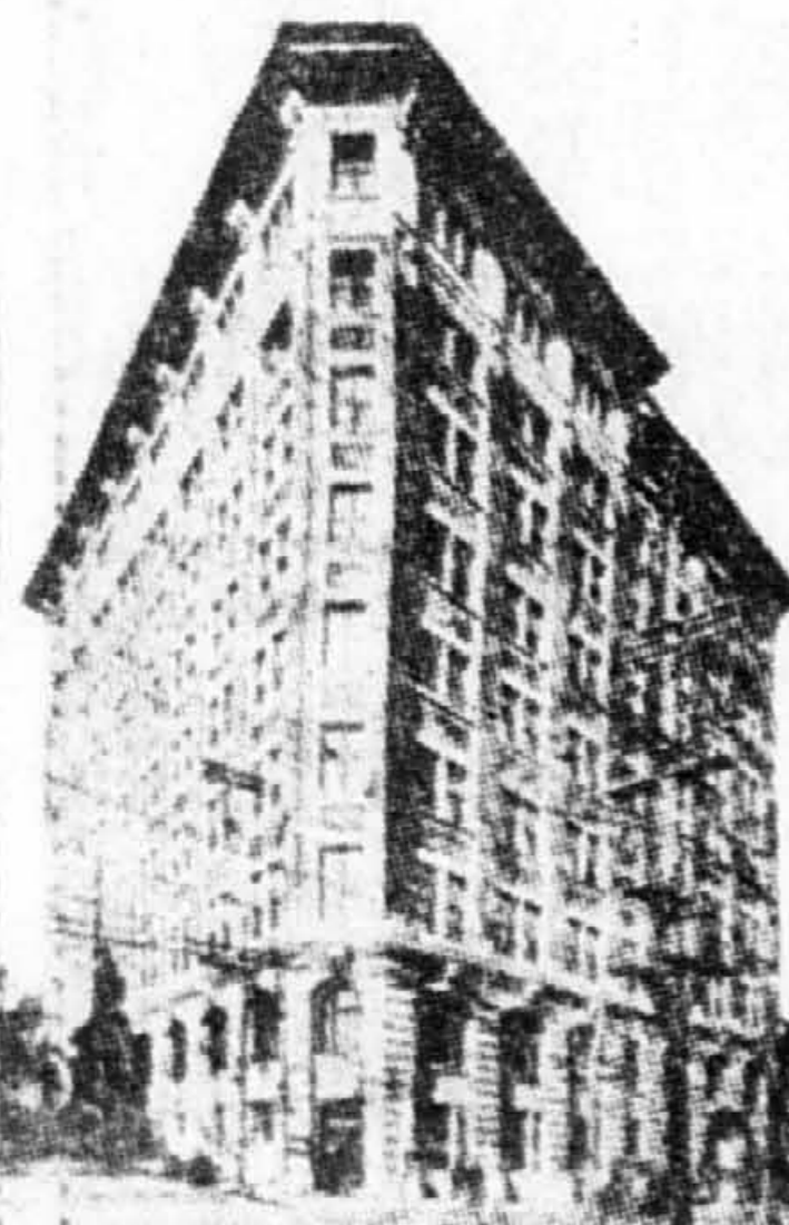
Le nouveau poste central Lancaster, installé au coin des rues Ontario et Saint-Urbain.
