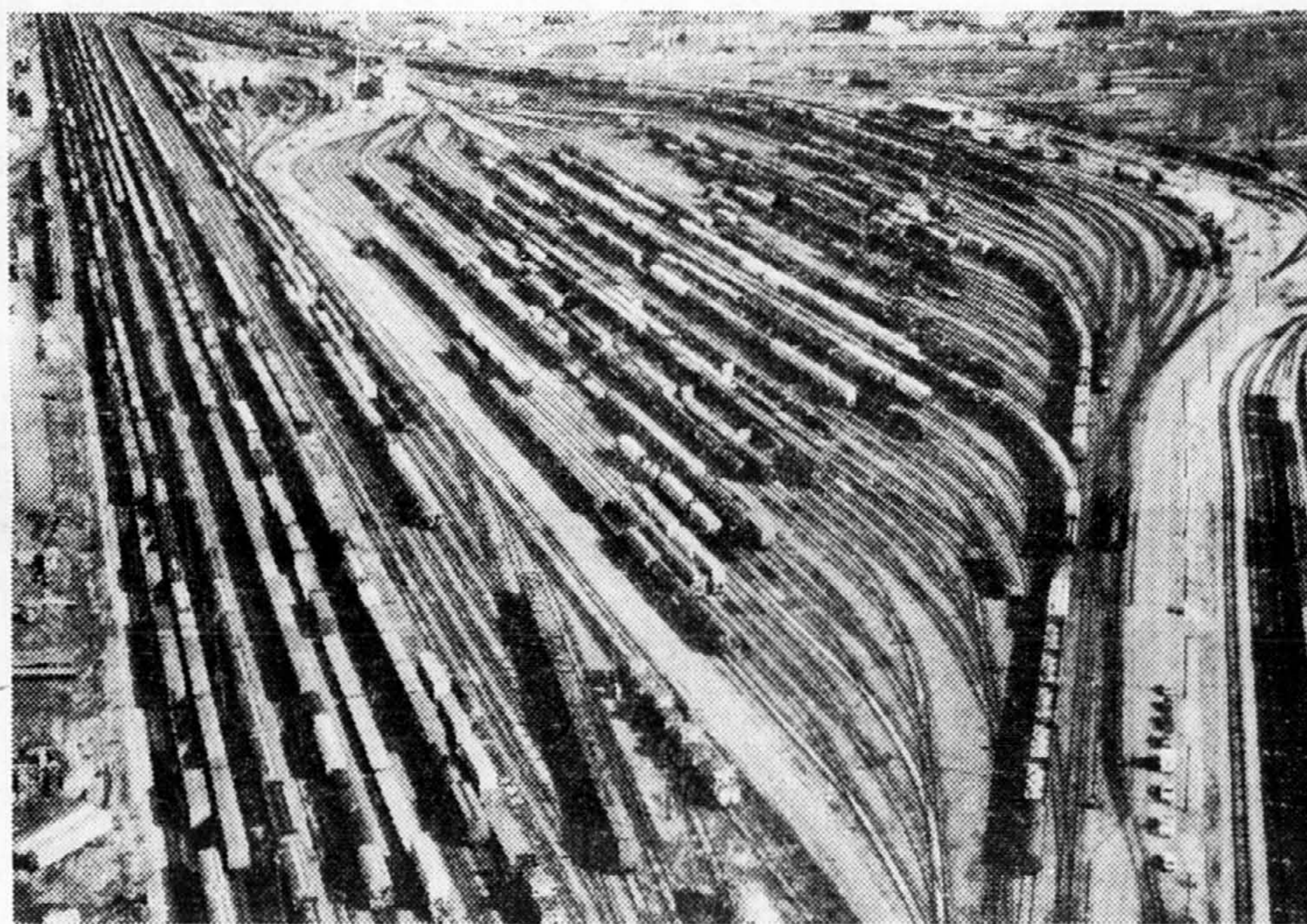
Chaque jour, jusqu'à 3 000 wagons de marchandises peuvent être formés en trains sur les 120 kilomètres de voies de la gare de triage Alyth de Calgary. Grâce à des investissements répétés, cette gare de triage d'une capacité quotidienne de 5 200 wagons compte parmi les plus automatisées et les plus perfectionnées d'Amérique du Nord.
