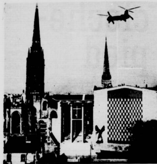
Suspendu à un hélicoptère, le nouveau clocher de bronze de deux tonnes est mis en place par une équipe de la R.A.F. L'opération exigeait une stricte précision. Il fallait reposer le clocheton de 80 pieds de haut sur une base d'une verge carrée.
