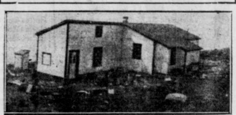
Photographie de l'habitation où demeurent les trois télégraphistes du sans-fil Marconi sur la pointe ouest de Belle-Ile.
