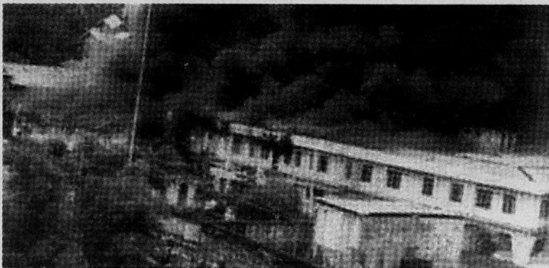
Le parlement de l'État du Manipur a été lourdement endommagé dans l'incendie.
