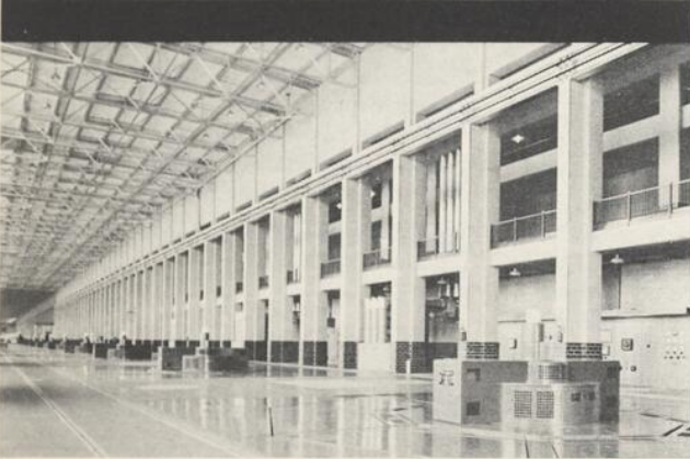
Vue de l'intérieur de la centrale.
