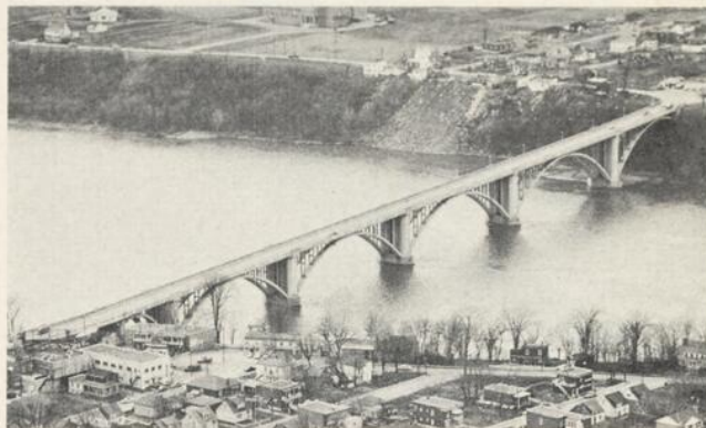
Le pont "Pie IX" dont la passerelle en béton est soutenue par des arches en "box girder" relie Montréal-Nord à Saint-Vincent-de-Paul.
