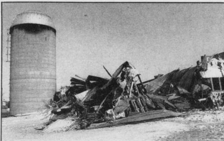
Il ne reste à peu près plus que des ruines, les pompiers ayant toutefois réussi à protéger le silo qui contenait des matières inflammables.
