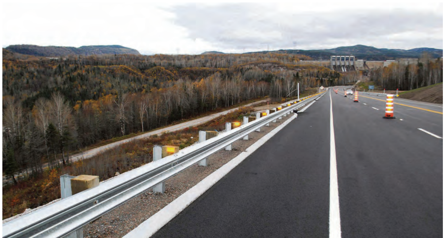
Autour du km 17 de la route 389, on a un aperçu de la nouvelle route à l'approche de Manic-2. À gauche et plus bas, c'est l'ancienne route qui sera renaturalisée. Photos MTQ
