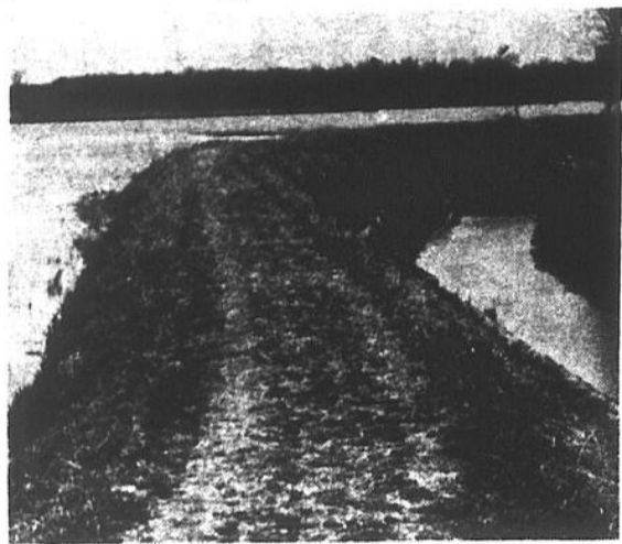
Les travaux d'endiguement ont déjà été approuvés par le ministère de l'Agriculture. (photo Michel Pétulli)
