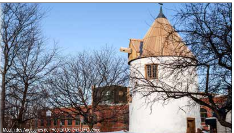
Moulin des Augustines de l'Hôpital-Général-de-Québec
