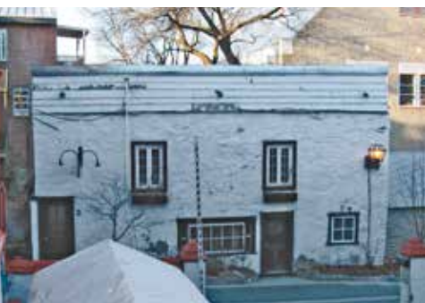
Ce bâtiment de la ruelle des Ursulines dans le Vieux-Québec a bénéficié du programme Maître d'œuvre. On le voit ici avant (en bas) et après sa restauration.
