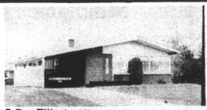
7 Des Tilleuls, Victoriaville. 5 1/2 pièces Electrique et air chaud. Propre. Terrain 14,407 p.c.
