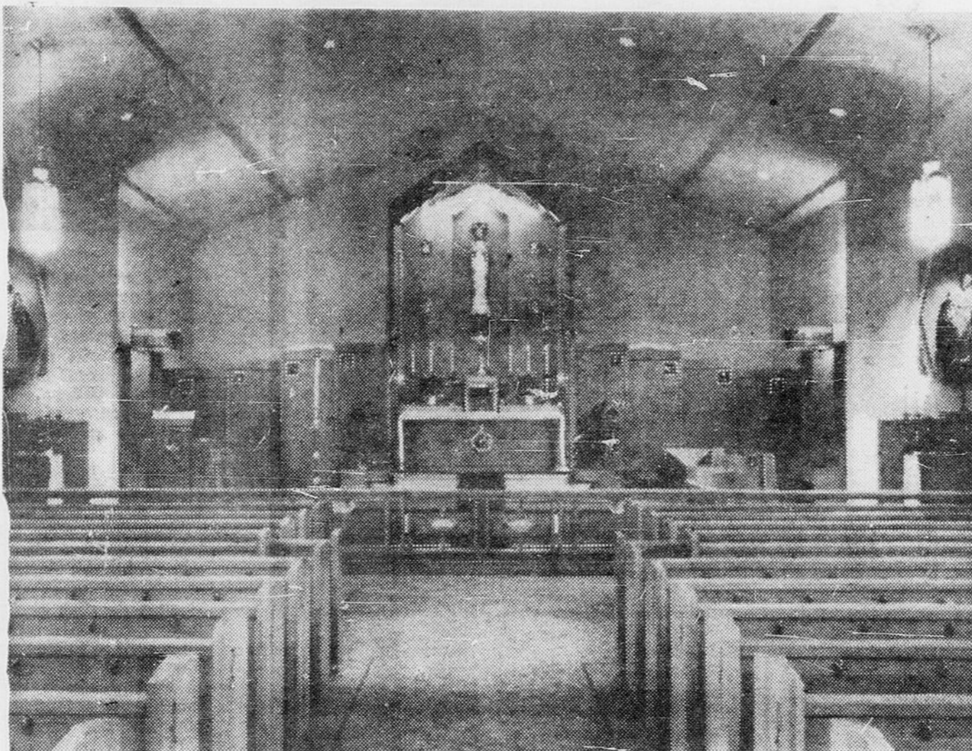
L'intérieur de l'église de la nouvelle paroisse du Sacré-Coeur à Manchester.
