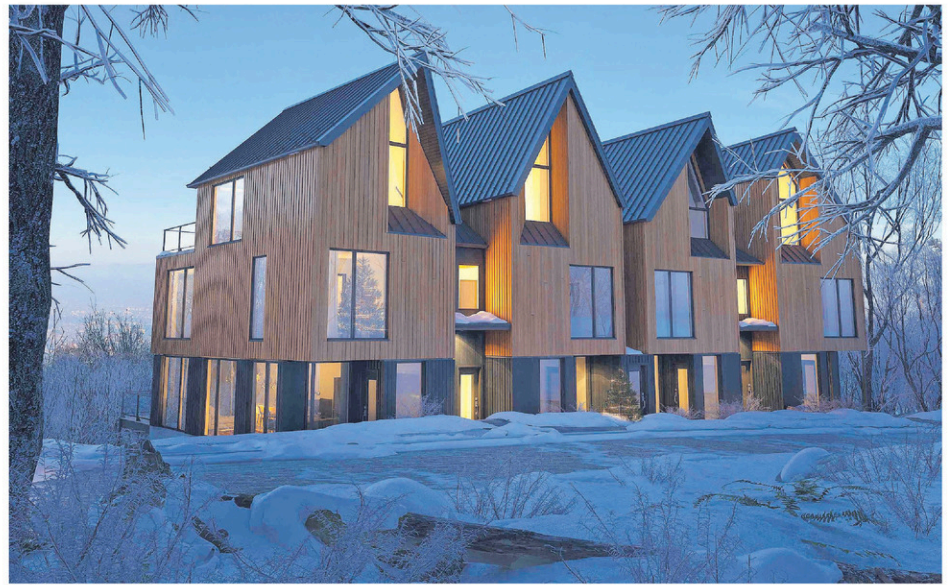
Le promoteur du projet Arborescence à Bromont, KnightsBridge, a soumis des avis d'intention conformément à la Loi sur la faillite et l'insolvabilité. (Photo: Gracieuseté - Porto-photo)
