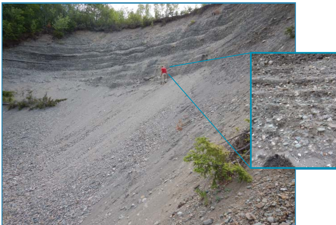
Photo 13: Face partiellement effondrée de 15 à 20 m de hauteur composée au sommet de 4 à 5 m de galets (40 à 60 %) avec quelques cailloux et de sable grossier stratifié horizontalement. Dans certains lits, les matériaux sont bien triés et sont sans structure alors qu'ils sont cimentés ailleurs (site 43, 22B15).
