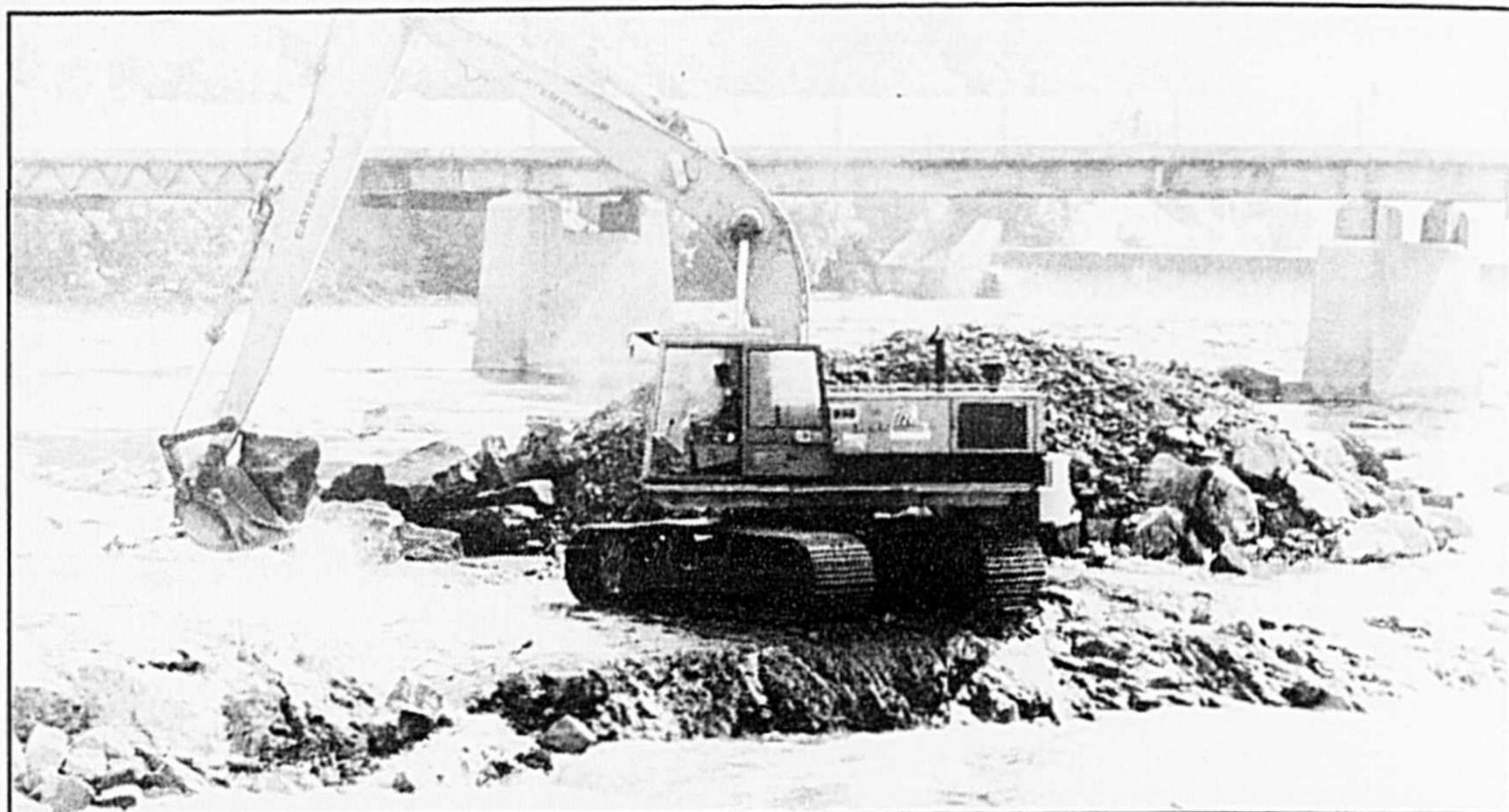
La semaine dernière, une pelle mécanique a ramassé des débris de roches et d'arbres près du canal de fuite de la centrale hydroélectrique. (Photo P.P.M.)
