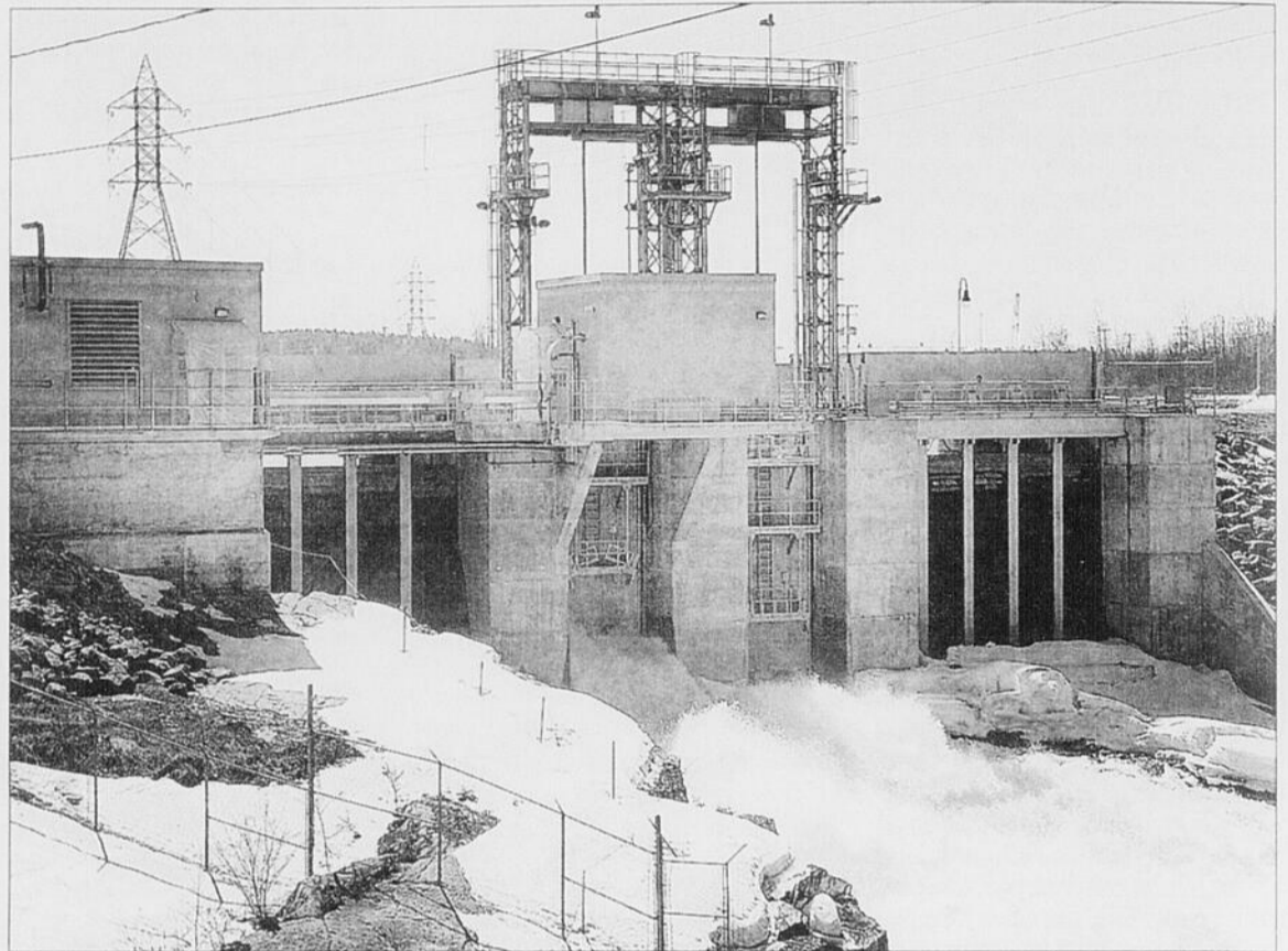
La somme de 7 millions$ que pourrait remettre Ottawa proviendrait d'une contribution monétaire de 0,01 $ du kilowatt-heure dès le moment où les centrales hydroélectriques de Pont-Arnaud et Chute-Garneau (photo) deviendront opérationnelles.
