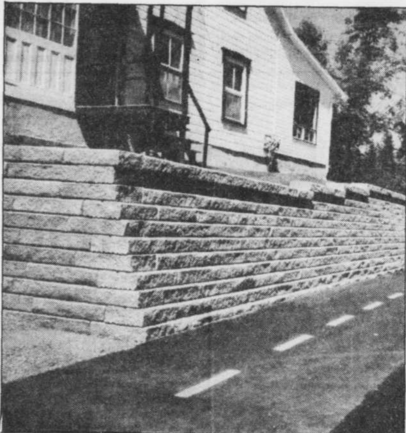
Un mur de soutènement fait de blocs Uni-Remblai à Fossambault. La firme Permacon affirme fabriquer des blocs plus résistants que la concurrence.
