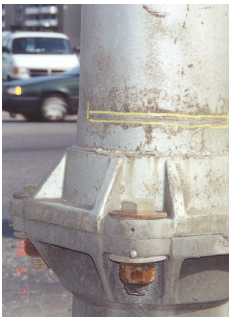
Photographie 5.5-5 Évaluation du comportement du poteau
