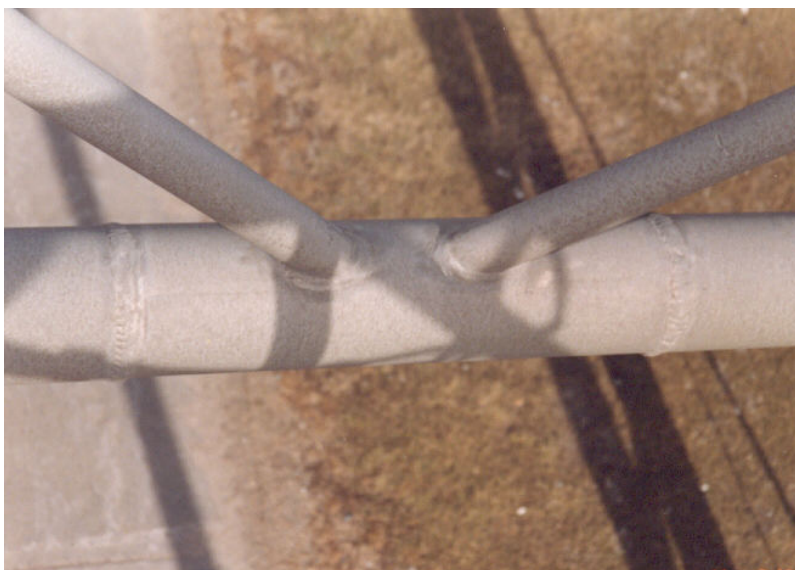
Photographie 5.6-16 Anomalie des longerons d'un support en treillis Anomalie – Deux parties d'un longeron unies par un assemblage soudé de qualité douteuse
