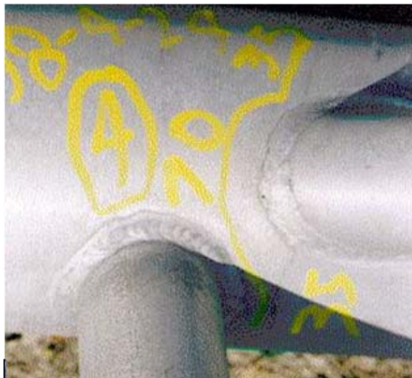
Photographie 5.6-2 Évaluation du comportement des longerons d'un support en treillis CEC 1 – Fissure affectant le contour de la soudure et se prolongeant dans le longeron
