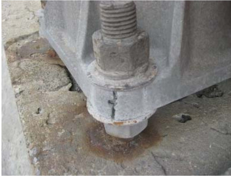
Photographie 5.4-15 Évaluation du comportement de la semelle d'ancrage
