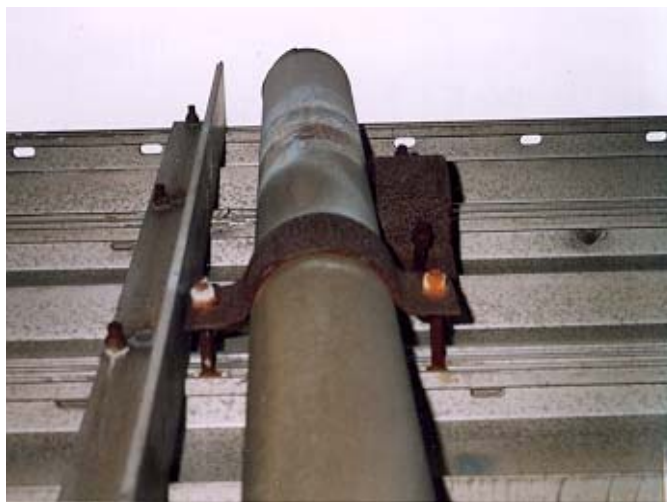
Photographie 5.10-6 Évaluation du comportement des attaches
