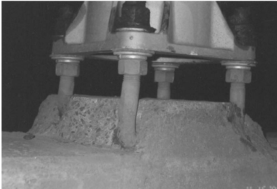
Photographie 5.4-10 Évaluation du comportement des tiges d'ancrage
