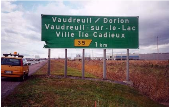
Photographie 5.10-1 Évaluation du comportement de l'extrusion CEC 1 – Extrusions endommagées de façon très importante par un impact
