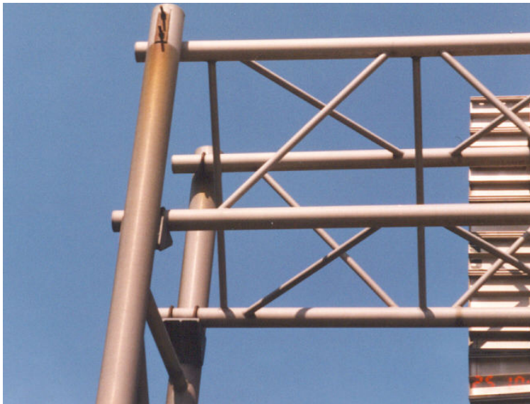
Photographie 5.6-12 Évaluation du comportement des membrures secondaires d'un support en treillis
