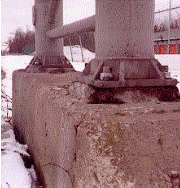
Photographie 5.4-12 Évaluation du comportement des tiges d'ancrage
