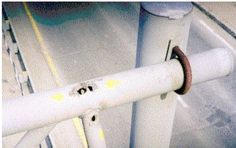
Photographie 5.6-8 Évaluation du comportement des longerons d'un support en treillis CEC 2 – Perforation, produite par une manipulation erratique du chalumeau, pouvant réduire de 15 à 20 % la capacité du longeron
