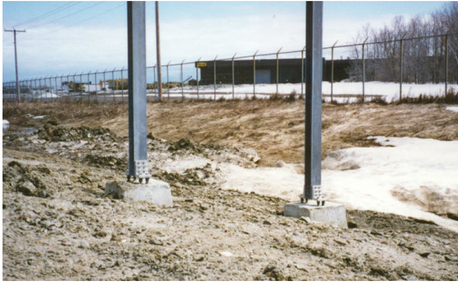
Photographie 5.3-9 Évaluation du comportement du remblai
