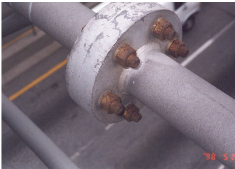
Photographie 5.8-4 Évaluation du comportement des assemblages boulonnés
