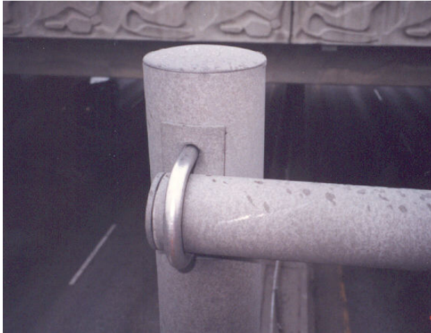
Photographie 5.6-14 Évaluation du comportement des longerons d'un support en treillis CEC 1 – Longeron trop court pour permettre un assemblage adéquat au support vertical
