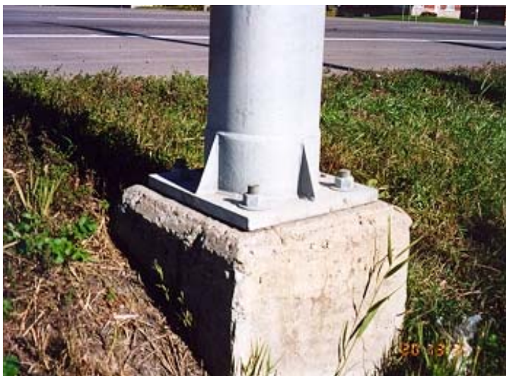
Photographie 5.3-7 Évaluation du comportement du remblai
