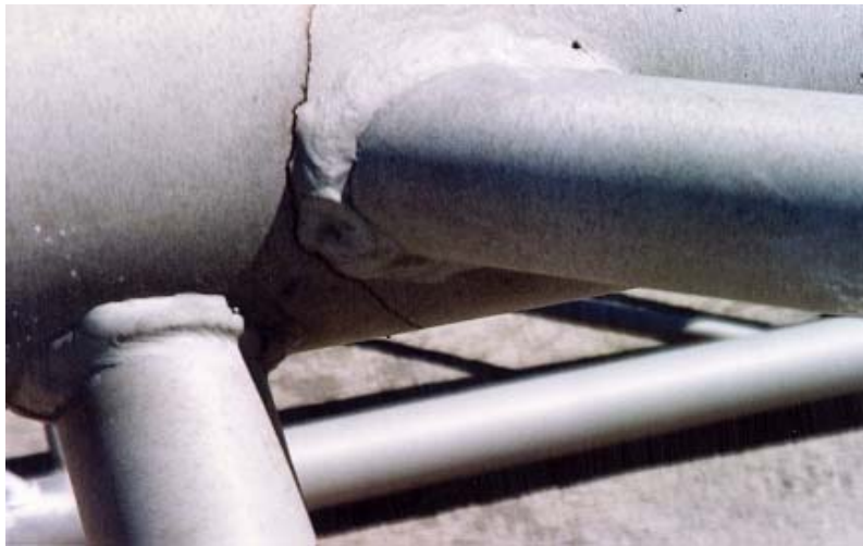
Photographie 5.6-1 Évaluation du comportement des longerons d'un support en treillis CEC 1 – Fissure affectant le contour de la soudure et se prolongeant dans le longeron
