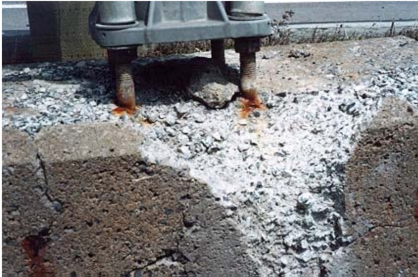
Photographie 5.4-2 Évaluation du comportement des tiges d'ancrage
