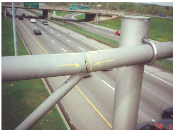
Photographie 5.6-6 Évaluation du comportement des longerons d'un support en treillis CEC 1 – Fissure attribuable au serrage excessif, en l'absence des cales nécessaires, du boulon d'assemblage du longeron au poteau du support vertical
