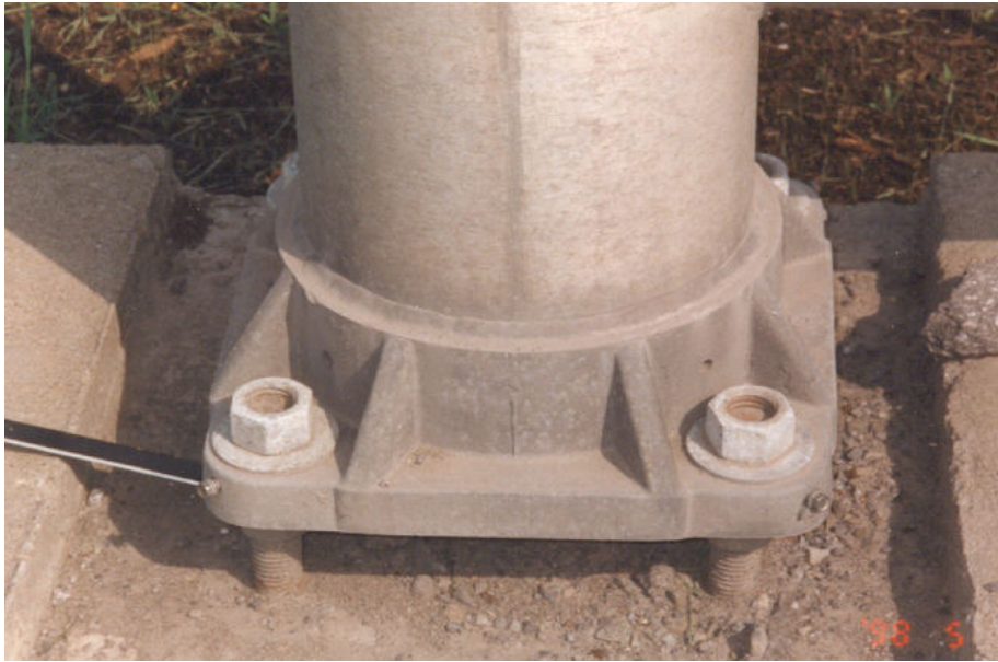
Photographie 5.4-11 Évaluation du comportement des tiges d'ancrage
