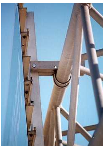
Photographie 1.5-8 – Éléments d'assemblage du panneau
