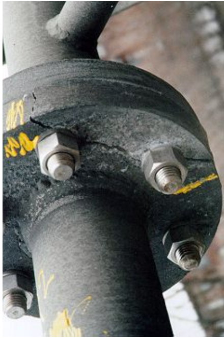
Photographie 5.8-1 Évaluation du comportement des assemblages boulonnés
