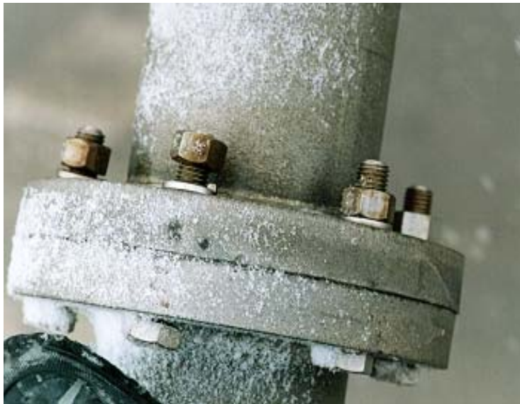
Photographie 5.8-2 Évaluation du comportement des assemblages boulonnés
