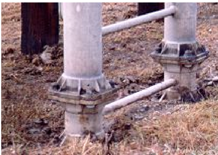
Photographie 5.3-8 Évaluation du comportement du remblai
