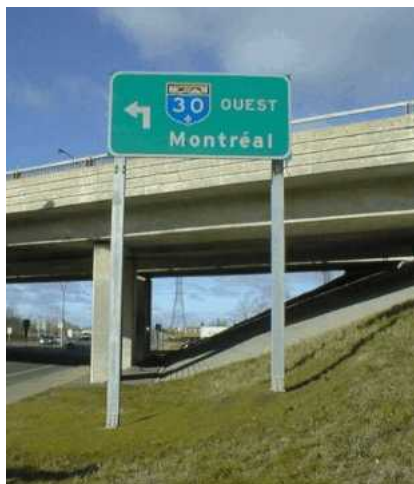
Photographie 1.4-7 – Structure de type L3X
