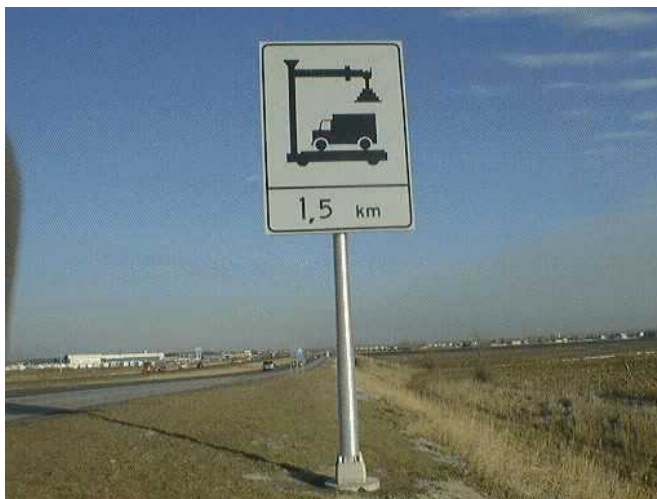
Photographie 1.4-9 – Structure de type L4X en aluminium
