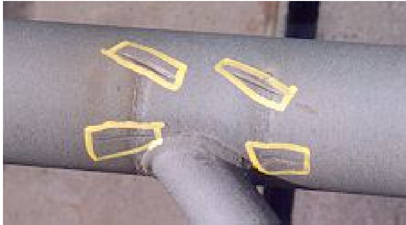
Photographie 5.6-7 Évaluation du comportement des longerons d'un support en treillis CEC 3 – Dommages, causés par des traits de scie, pouvant réduire de 10 à 15 % la capacité du longeron
