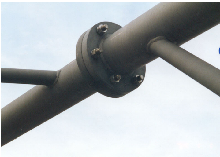
Photographie 5.6-11 Évaluation du comportement des membrures secondaires d'un support en treillis
