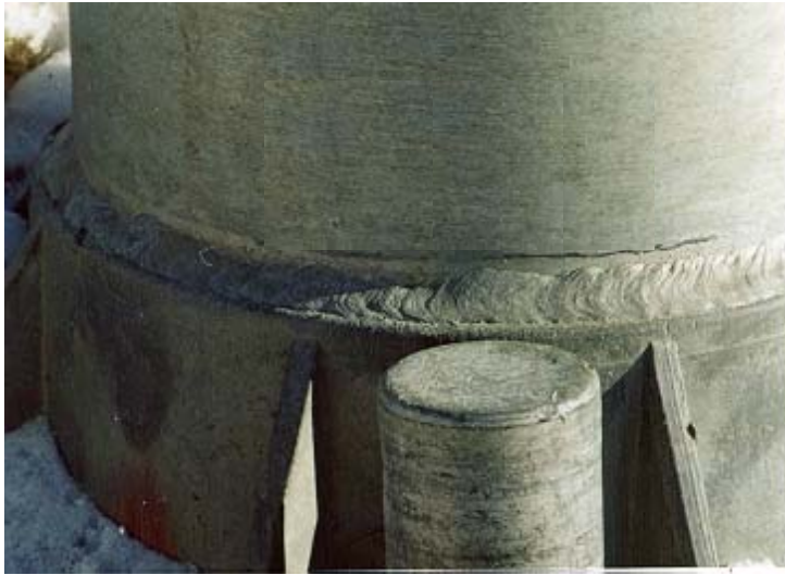
Photographie 5.5-2 Évaluation du comportement du poteau
