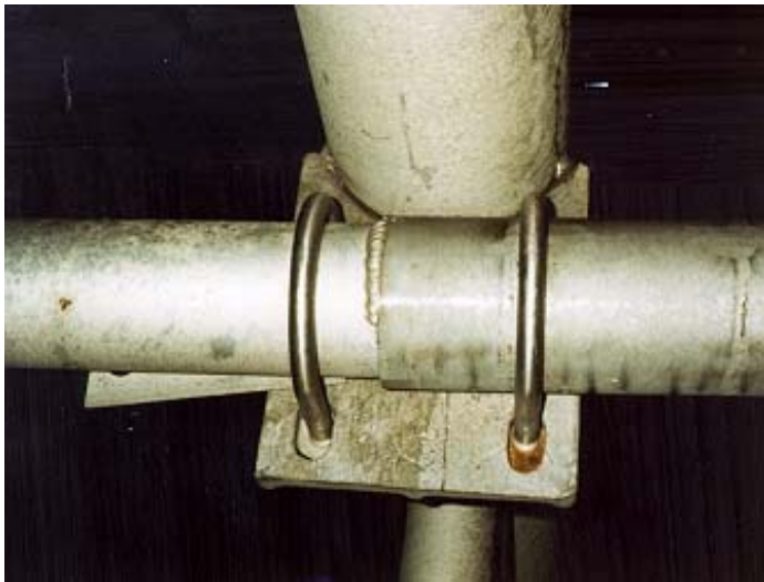
Photographie 5.6-15 Anomalie des longerons d'un support en treillis Anomalie – Travaux d'allongement d'un longeron de qualité douteuse
