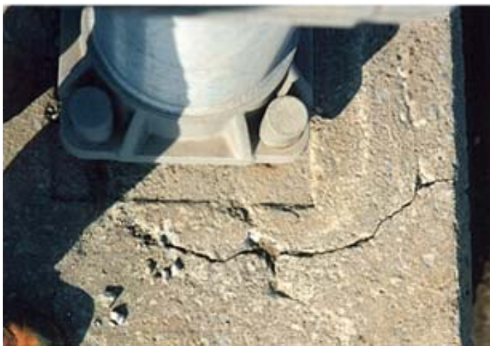
Photographie 5.3-6 Évaluation du comportement du massif de fondation
