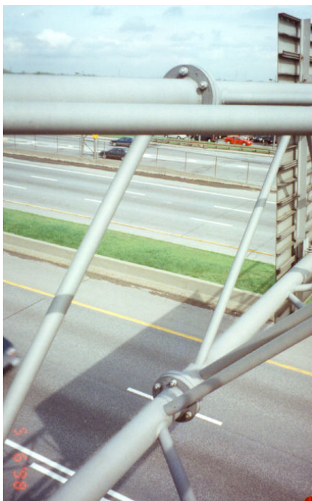
Photographie 5.6-10 Évaluation du comportement des membrures secondaires d'un support en treillis
