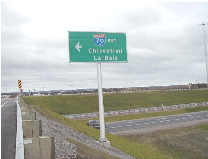
Photographie 1.4-8 – Structure de type L4
