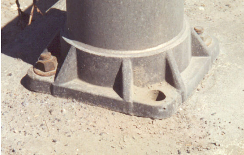
Photographie 5.4-7 Évaluation du comportement des tiges d'ancrage
