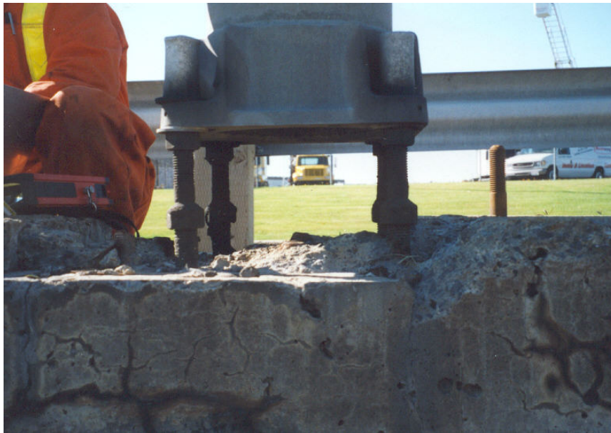
Photographie 5.4-9 Évaluation du comportement des tiges d'ancrage CEC 1 – Longueur non supportée des tiges d'ancrage 1¼" supérieure à 110 mm
