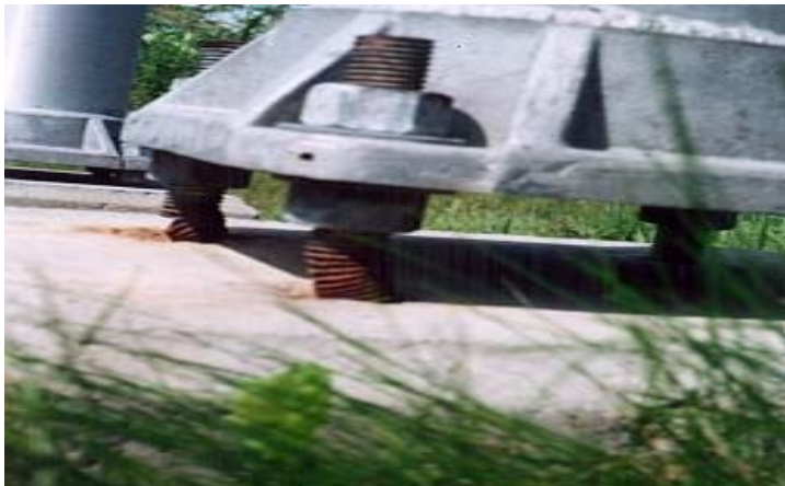
Photographie 5.4-6 Évaluation du comportement des tiges d'ancrage
