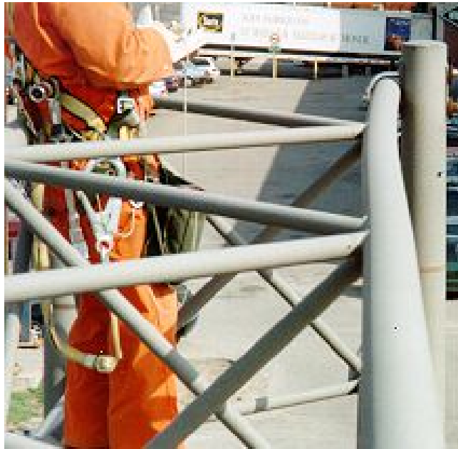
Photographie 5.6-5 Évaluation du comportement des longerons d'un support en treillis CEC 2 – Fléchissement du longeron attribuable au serrage excessif du boulon d'assemblage du longeron au poteau du support vertical en l'absence des cales nécessaires, affectant de façon importante sa capacité
