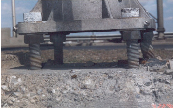
Photographie 5.4-5 Évaluation du comportement des tiges d'ancrage
