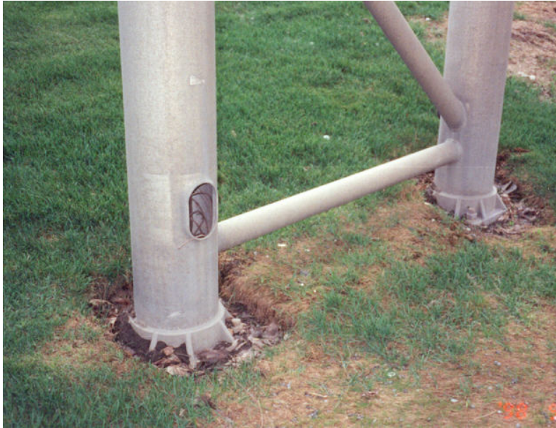
Photographie 5.3-5 Évaluation du comportement du massif de fondation
