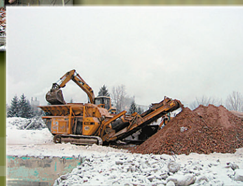
Démolition de l'ancien pensionnat indien de La Tuque pour le CPE Premier Pas (photo : valorisation par concassage d'environ 10 000 tonnes métriques de béton, maçonnerie). Principal partenaire pour la démolition : Construction Arctic Béluga inc.
