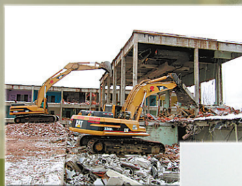
Démolition de l'ancien pensionnat indien de La Tuque pour le CPE Premier Pas (photo du gymnase, janvier 2006). Principal partenaire pour la démolition : Construction Arctic Béluga inc.
