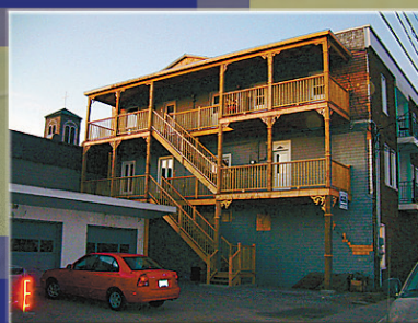
Rénovation commerciale au centre-ville de La Tuque (galerie).
