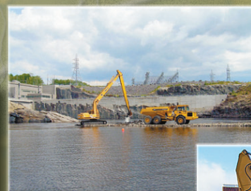
Excavation dans le bief aval, Centrale Du-Rocher Grand-Mère Hydro-Québec, pour Laval Fortin liée d'Alma (photo août 2006). Principal partenaire pour la l'excavation : Construction Arctic Béluga inc.
