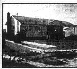
Près du Cégep, const. 92. 3 ch., abri d'auto, cheminée
