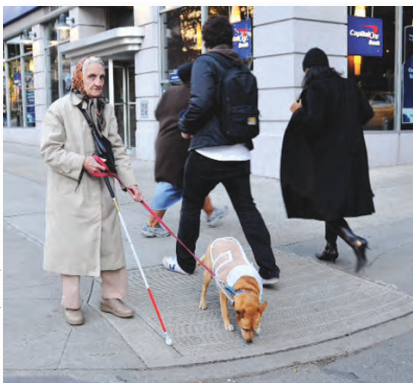
À l'intersection, le trottoir surabaissé facilite le déplacement des fauteuils roulants et le pavage texturé permet aux personnes ayant des incapacités visuelles d'être averties de l'intersection.
