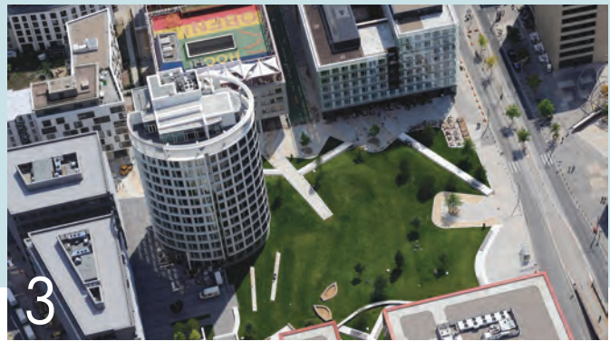
3 Vue aérienne de Sandtorpark et du toit de Katharinenschule.
