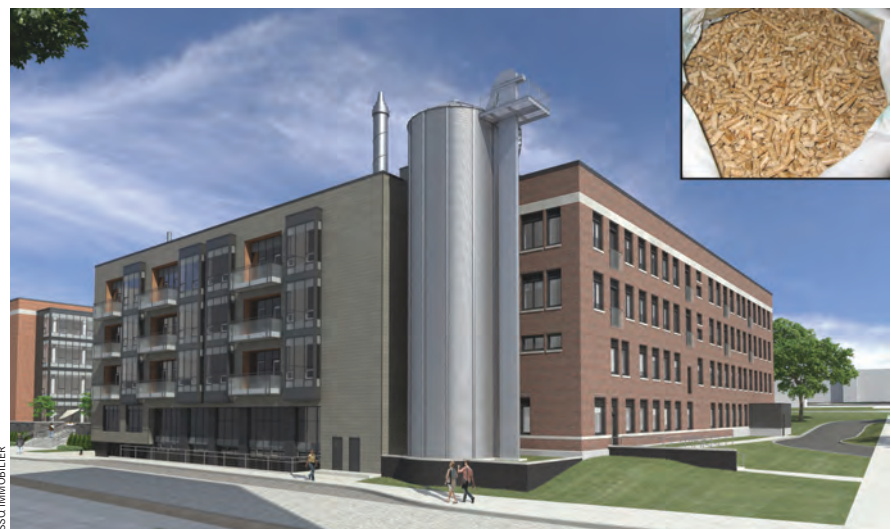
Les installations du système de chauffage urbain de la Cité Verte
