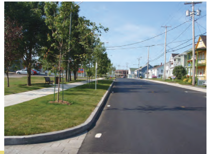
L'avenue Saint-Jérôme suite aux travaux de réfection.
