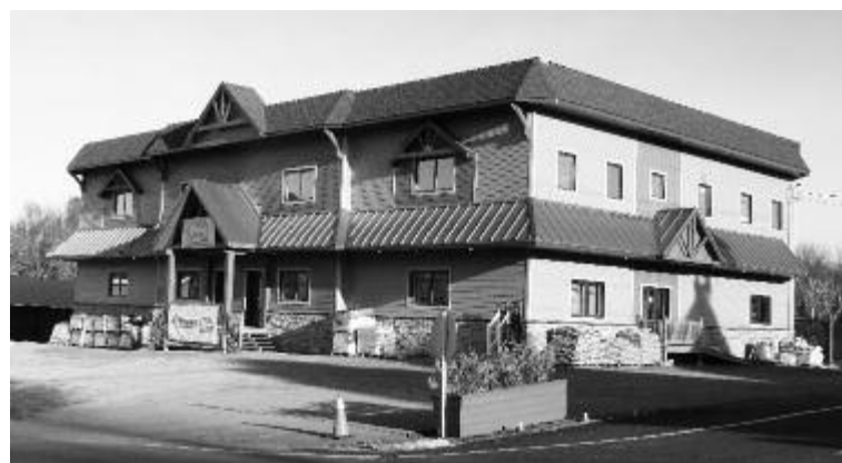
Nouvelle bâtisse d'Unimat
