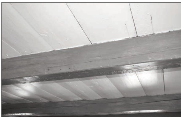
Lorsque le dessous des planches qui fait office de fini de plafond est déjà peint, il suffit de bien le nettoyer et de le repeindre.
