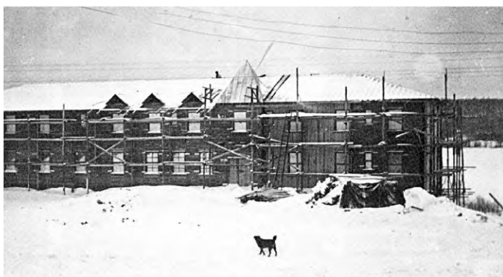
La construction du Manoir en 1948 Coll. Manoir Lac Etchemin
