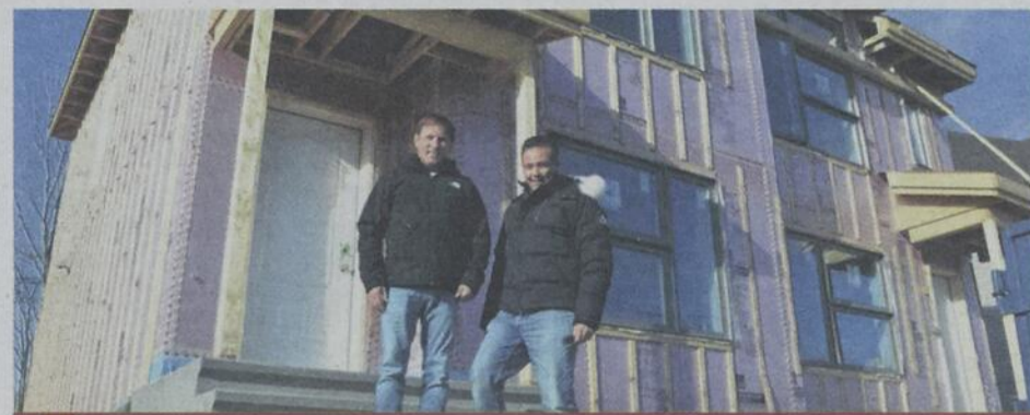
Guy Lacourse et Salvatore Ciarlo posent ici devant l'enveloppe étanche de l'une des résidences de Constructions Lacourse dans le secteur de la Seigneurie du lac Long. (Photo : Karine Limoges)
