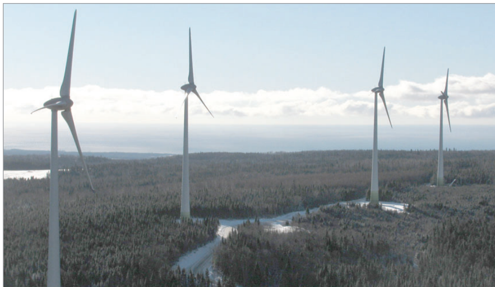
Le parc éolien de TransAlta a une puissance de 68 MW générée par 33 éoliennes de type Enercon. PHOTO COURTOISIE.
