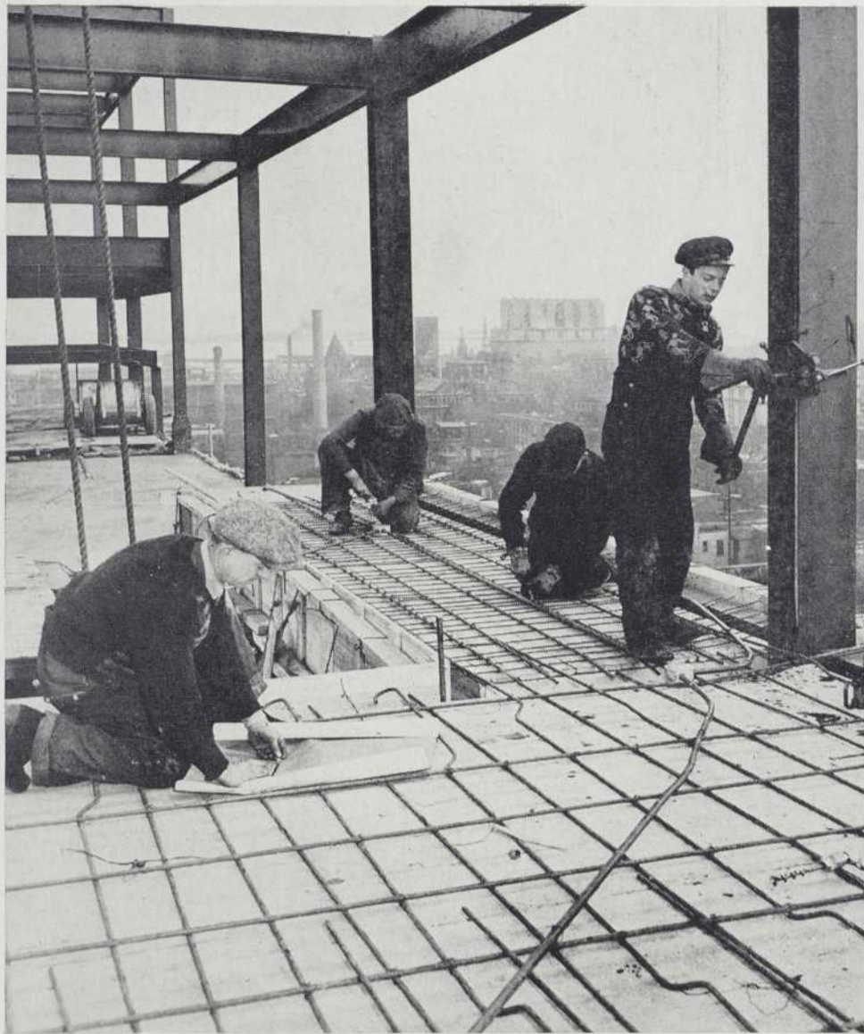
Voici une de nos équipes de techniciens en train d'installer des conduits dans les planchers de béton chez Dupuis Frères, Ltée. Ces travaux se poursuivent dans l'aile nouvelle présentement en construction, rue Saint-André.
