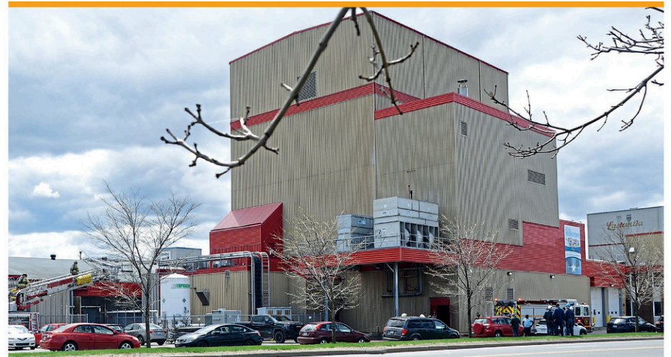
Des travaux de soudure ont causé le début d'incendie. (Photo www.lanouvelle.net)
