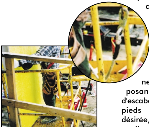
Sur une plate-forme girafe, il faut s'attacher en tout temps à l'ancrage de la plate-forme.
