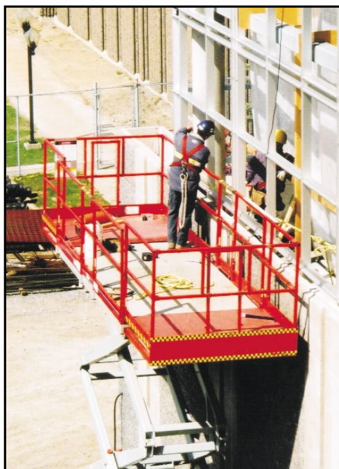
La plate-forme à ciseaux tout-terrain offre une grande surface de travail.
