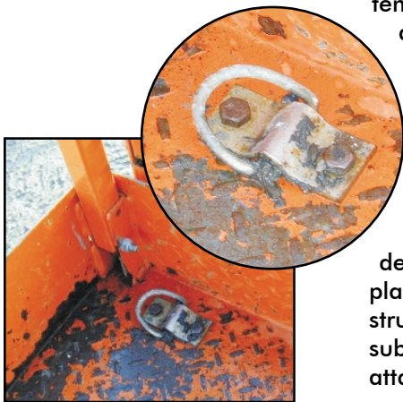
Si les règles de votre chantier stipulent que vous devez vous attacher sur une plate-forme à ciseaux, c'est à l'ancrage de celle-ci ou à un élément de la structure du bâtiment que vous devez le faire.
