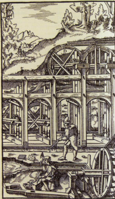
A: Première machine B: Ses pilons C: Son coffre D: Deuxième machine E: Ses pilons F: Son coffre G: Troisième machine H: Ses pilons I: Son coffre K: Quatrième machine L: Ses pilons M: Son coffre
