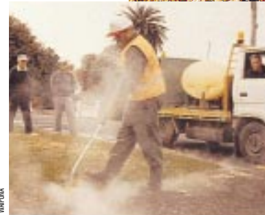
Destruction par eau chaude sous pression
