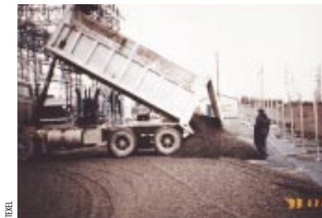
Répression par utilisation de membrane géotextile
