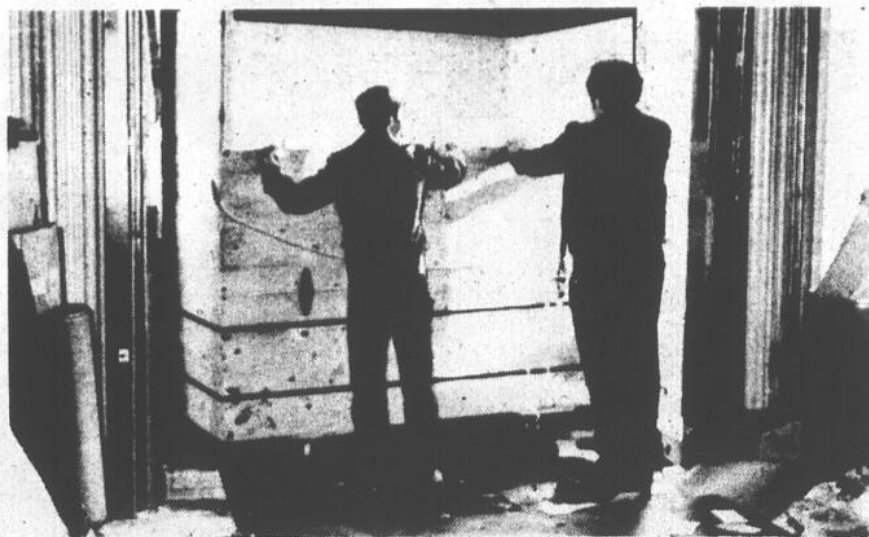
C'est le moment de procéder au déchargement du camion.
