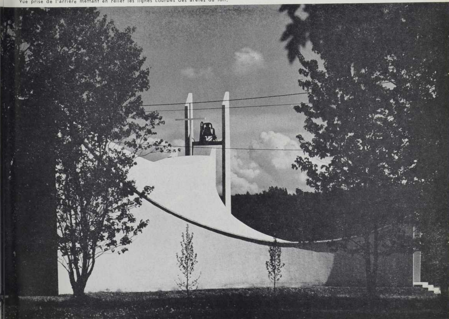
Vue prise de l'arrière mettant en relief les lignes courbes des arêtes du toit.
