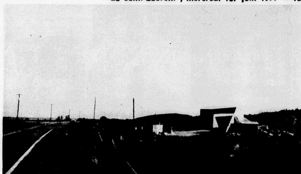
VIADUC CONSTRUIT SUR LE PARCOURS DU TRONCON PELLETIER - ST-ANDRE
