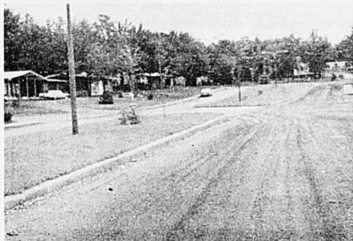
Rue Grande Allée, de Pageau à Du Parc.
