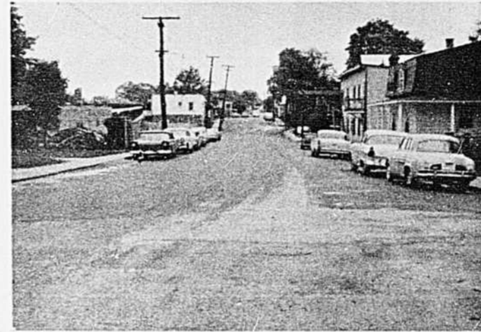
Rue St-Joseph, nouvellement refaite à neuf.
