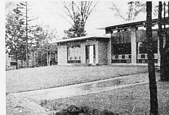
Propriété de M. Gilles Locas, à l'extrémité est de la rue Du Parc.
