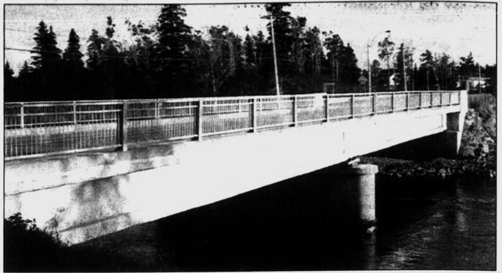
Les ponts de la route 138, dont celui sur la rivière Trinity (notre photo), n'ont pas souffert du déluge qui s'est abattu sur la région les 19 et 20 juillet.
