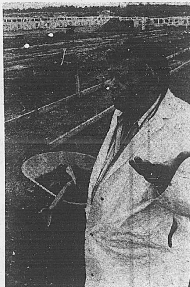
Le propriétaire du Chenil Laval, M. Etienne Pesant, veille personnellement aux travaux d'érection de la nouvelle bâtisse qui sera ouverte cet automne.
