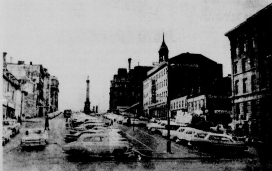
La Place Jacques-Cartier, malgré ses transformations, conserve un peu de la fraîcheur du régime français. On y voit toujours des maisons à lucarnes et aux toits en pente. A l'époque, elle n'existait pas, mais son emplacement éventuel voisinait le château de Philippe de Rigaud de Vaudreuil, gouverneur de la Nouvelle-France. Après la conquête, le château abrita le collège de Montréal.
