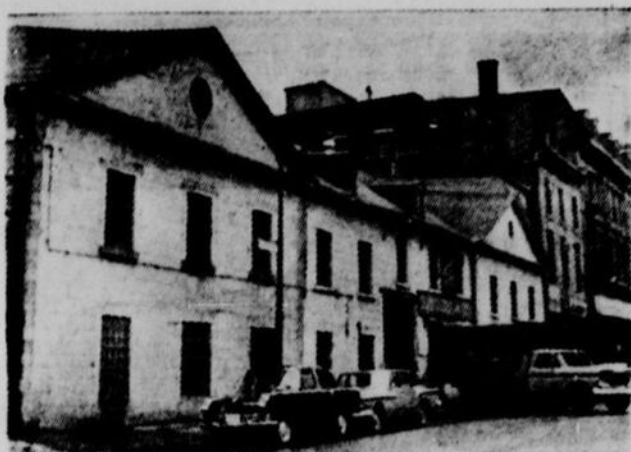
Au XVIII e siècle, la communauté des Frères Charron s'émietta, leur hôpital périclita. Madame d'Éouville récupéra l'immeuble, dont on voit la façade, et y fonda la communauté des Soeurs Grises. A l'intérieur de l'hôpital Général, les poutres et solives sont aussi solides qu'aux beaux jours de la colonie française.
