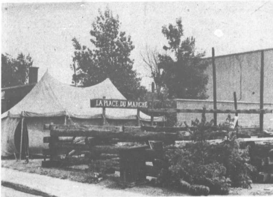
La Place du Marché contiendra au moins une trentaine d'étables ainsi que des animaux de ferme et domestiques. Les énormes poutres entrecroisées que l'on voit ici, serviront d'enclos aux gros animaux.
