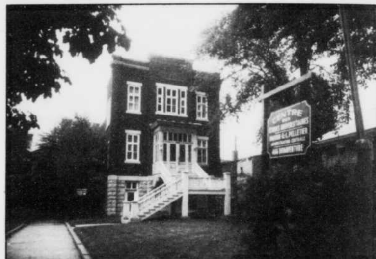
Cette maison de la fin du siècle dernier, toujours située à 466 de la rue Bonaventure à Trois-Rivières, a été utilisée par l'Université du Québec à Trois-Rivières de 1969 à 1974, alors que la majorité des Pavillons de l'Université étaient répartis au centre-ville. Connue sous le nom de Pavillon Pelletier, ce pavillon rendait hommage à l'évêque de Trois-Rivières.
