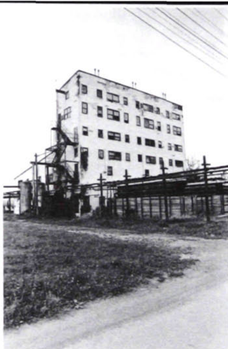
Ville dans la ville, le site d'Expro comprend plusieurs bâtiments, plus ou moins occupés.
