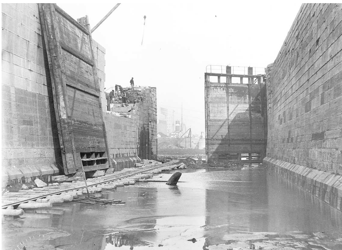
Un changement de portes d'écluses en 1903.
