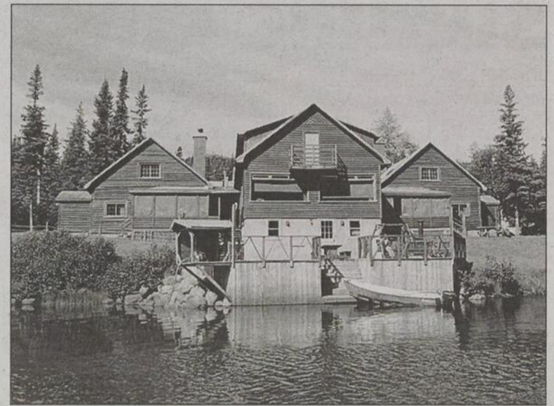
Le site des Portes-de-l'Enfer compte neuf chalets tout équipés avec l'électricité et un territoire de 25 lacs.
