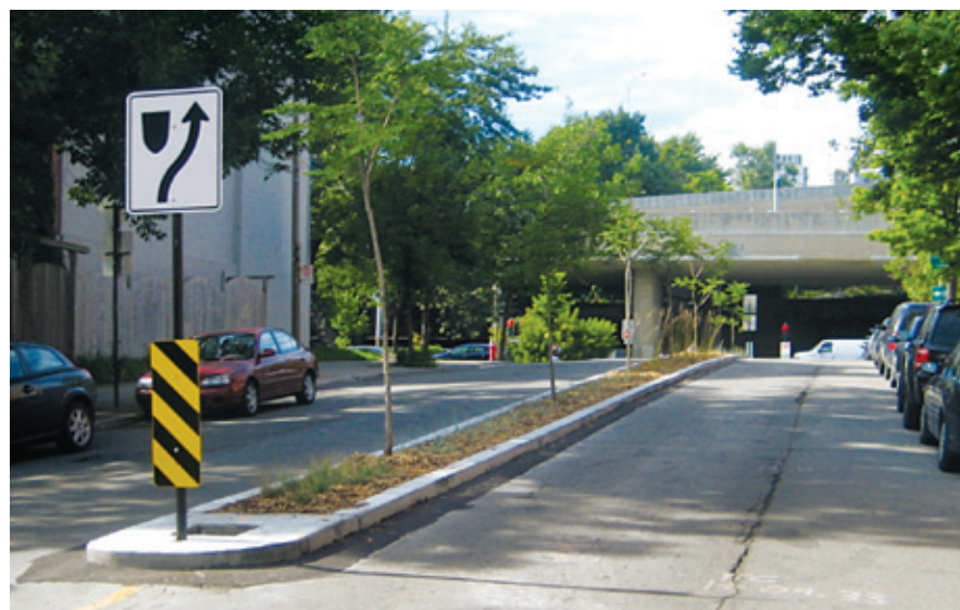
Le nouveau terre-plein avec plantation d'arbres aménagé sur Georges-Vanier, au coin de la rue Saint-Antoine, favorise à la fois la réduction de la vitesse et le verdissement.
