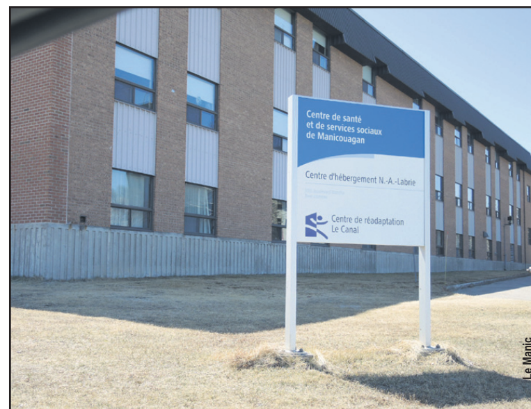
Le Centre d'hébergement N.-A.-Labrie et le Centre d'hébergement Boisvert font partie des sept établissements de soins de longue durée de la Côte-Nord ayant obtenu un code rouge lors du dernier passage des inspecteurs du ministère de la Santé et des Services sociaux.
