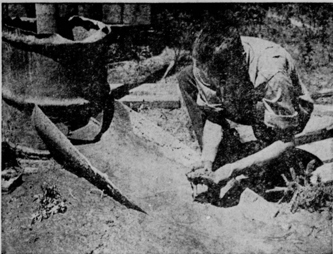
Au cours des travaux de forage effectués en 1955, on remonta du fonds du puits de la boue qui avait la consistance du ciment liquide. Malheureusement, les travaux furent interrompus à cause de l'inondation régulière du puits.
