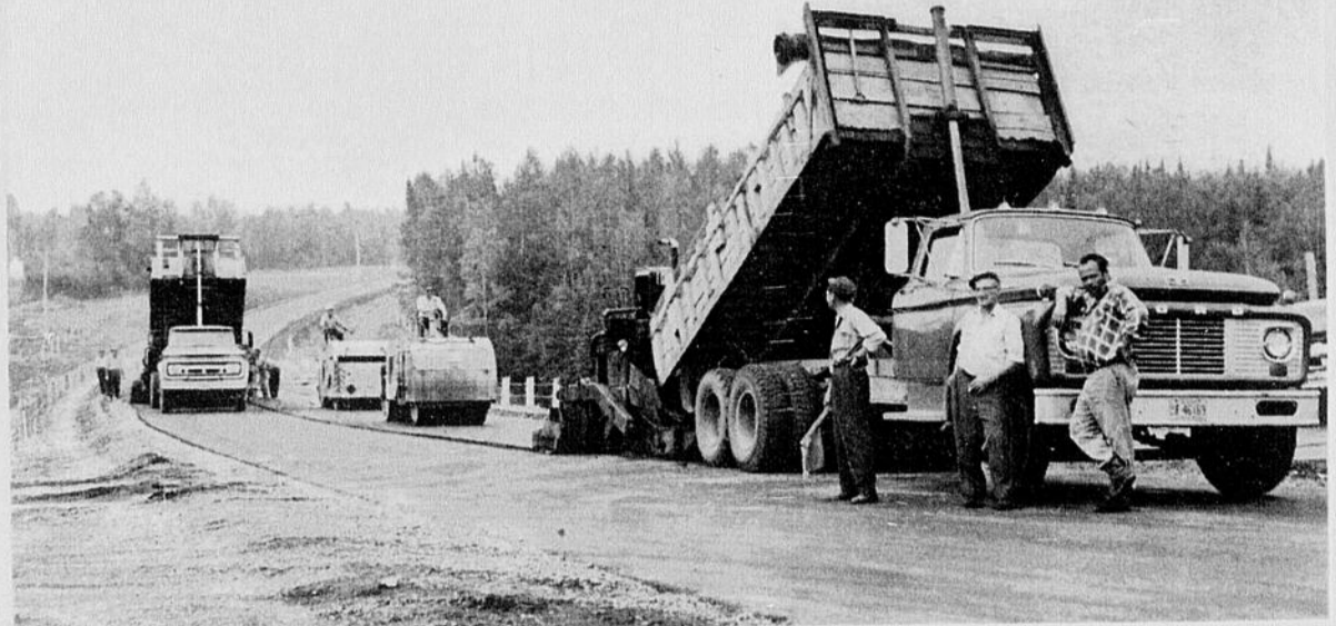
ROUTE A ST-THEOPHILE — Depuis quelque temps, des travaux de réfection et de revêtement bitumineux, sur une longueur de 13 1/2 mille ont été complétés près de la paroisse St-Théophile dans le comté de Beauce. Ces améliorations routières, sur
