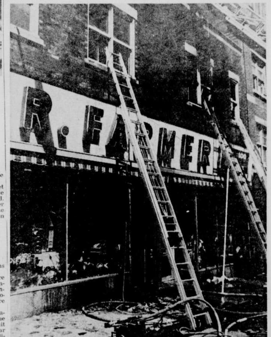
Un incendie qui s'est déclaré vers l'heure du midi au 1014 rue St-Jean dans la Haute-Ville de Québec hier a ravagé l'intérieur de l'établissement qui comportait le magasin Farmer au rez-de-chaussée et des chambres à l'étage supérieur. L'incendie qui a nécessité trois alertes a cependant été maîtrisé assez rapidement par les sapeurs. (Photo, Mario Roy)
