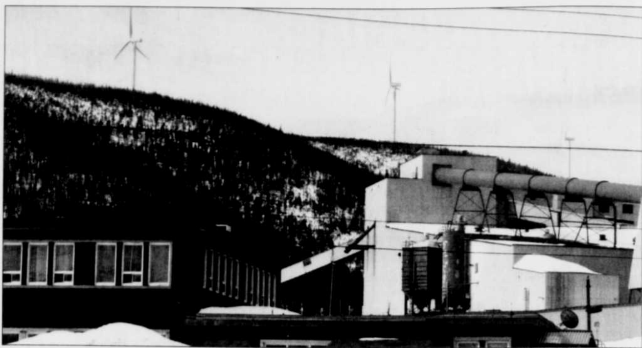
Le Centre sera situé dans l'ancien bâtiment administratif de Mines Gaspé. À l'arrière-plan, des éoliennes de 3Ci
