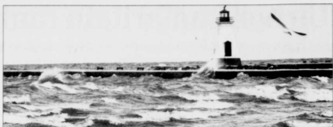
La Commission mixte internationale a déploré à de nombreuses reprises la détérioration de la qualité de l'eau des Grands Lacs, en raison de contaminations toxiques.
