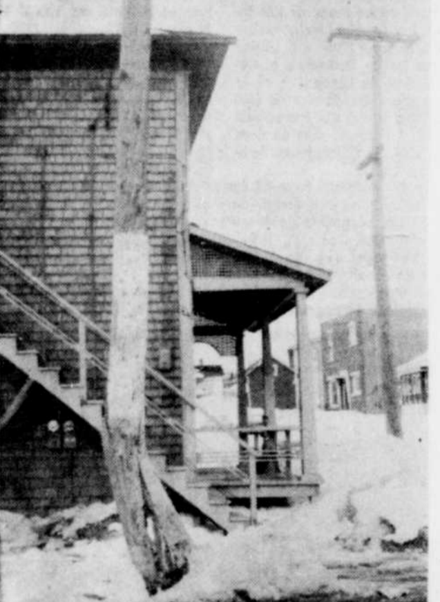
SITUATION PERILLEUSE — Un poteau supportant de nombreux câbles électriques se trouve dans une position pour le moins périlleuse à l'angle des rues Rousseau et Bolduc, à Thetford Mines. A la suite d'un choc reçu à sa base, le poteau a subi des dégâts tels, qu'il risque de s'affaisser à la moindre secousse. Le remplacement est évident; nul doute qu'il sera effectué incessamment. (Photo La Tribune, Thetford Mines)
