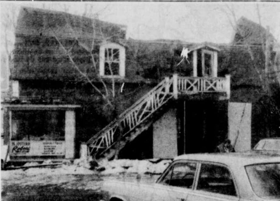
LOURDS DOMMAGES MATERIELS — Le feu a causé de lourds dommages matériels à la Bijouterie Robert, rue Hériot, à Drummondville, hier matin. Le toit de la bijouterie qui s'est écroulé.
