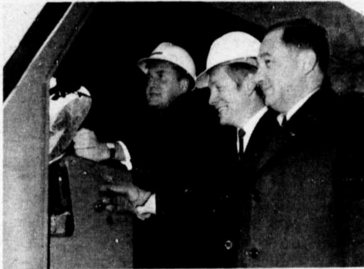
Le député de Richelieu, M. Maurice Martel, le maire Georges Tétréault, du village de Contrecoeur, et l'ingénieur Maurice Beaudry, actionnant la pelle mécanique au cours de la cérémonie de lancement des travaux de l'usine de filtration de Contrecoeur.
